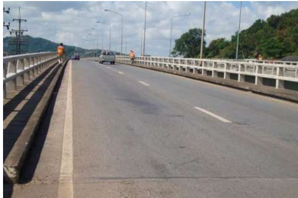
สะพานฝั่งซ้ายทาง (สะพานเดิม)
