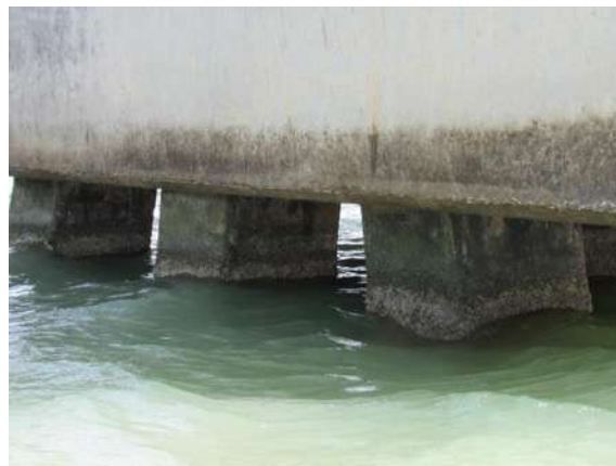
(ช) เสาค้ำ สังกะสีบริเวณแคบ
