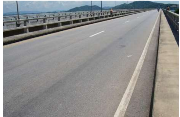
สะพานฝั่งขวาทาง (สะพานใหม่)
